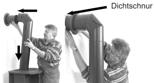
Abb. 5: Montage Rauchrohr
