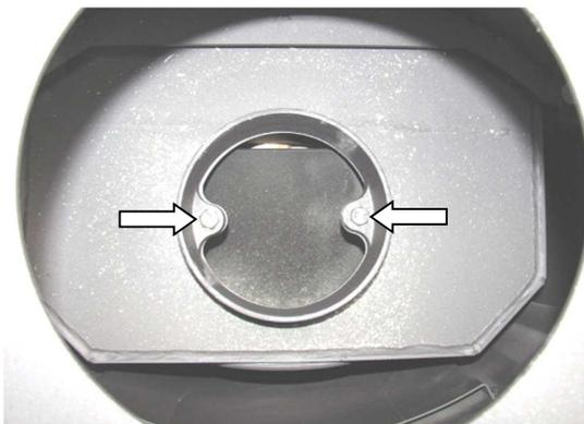
Abb. 7: Schrauben Rauchgasstutzen
