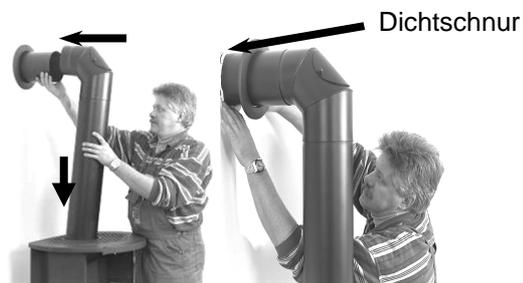
**Abb. 5: Montage Rauchrohr**
