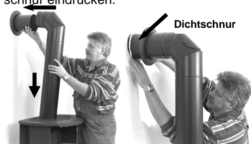
Abb. 8: Montage Rauchrohr
