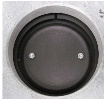
Abb. 11: Blinddeckel vertikal
