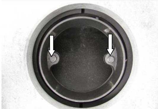
Abb. 6: Schrauben Rauchrohrstutzen
