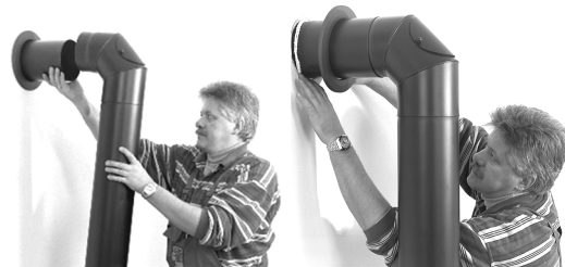
Abb. 5: Anschluss Rauchrohr am Schornstein
