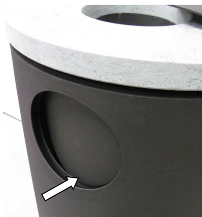
Abb. 8: Ausbruch horizontaler Anschluss
