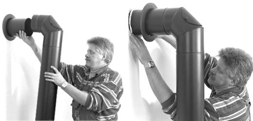
Abb. 12: Anschluss Rauchrohr am Schornstein
